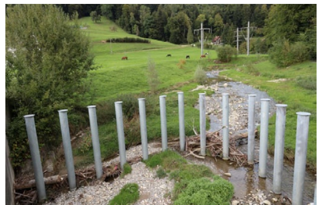
Beispiel einer Schwemmhholzsperrung am Ernetschwilerbach in Uznach.
