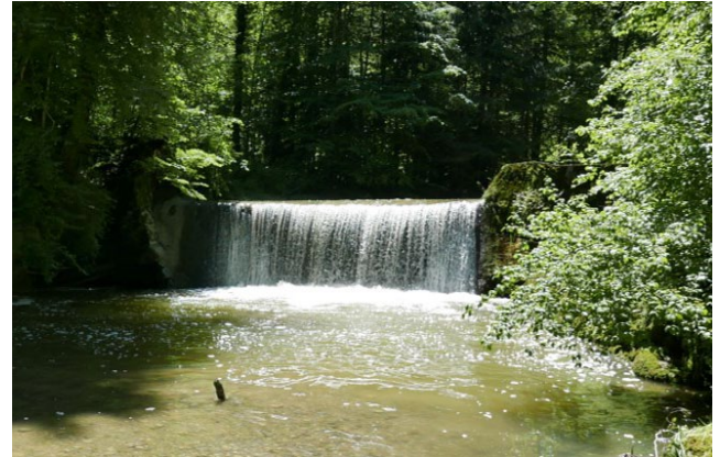
Die bestehenden hohen Betonsperrungen sollen zurückgebaut werden.
